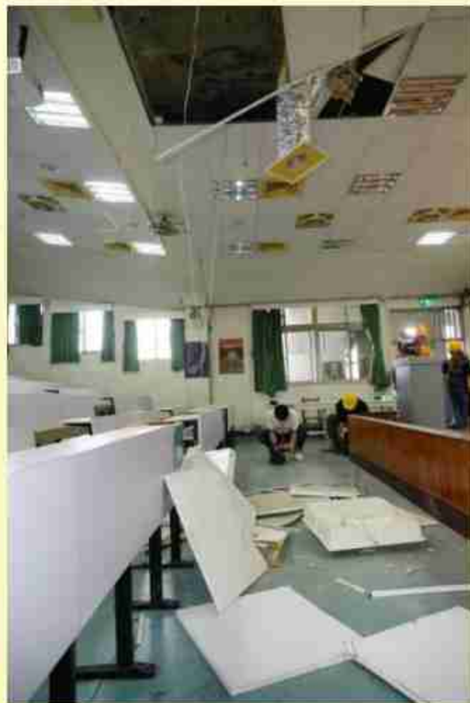
梁底混凝土剝落、天花板掉落
