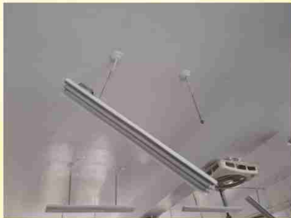
樓梯間混凝土剝落、燈具受損
