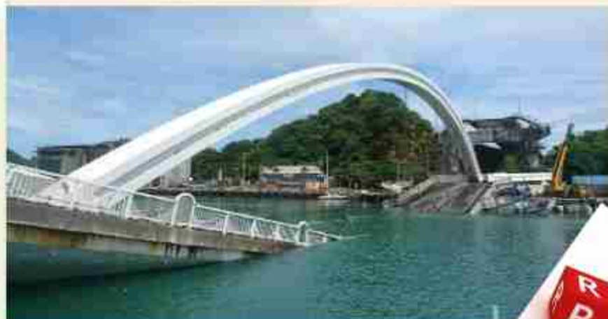
1081001南方澳大橋坍塌意外(6死、13傷)
