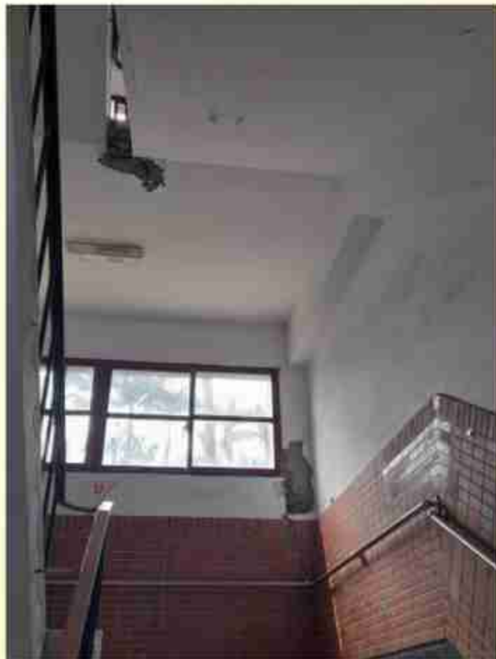
樓梯間混凝土剝落、燈具受損
