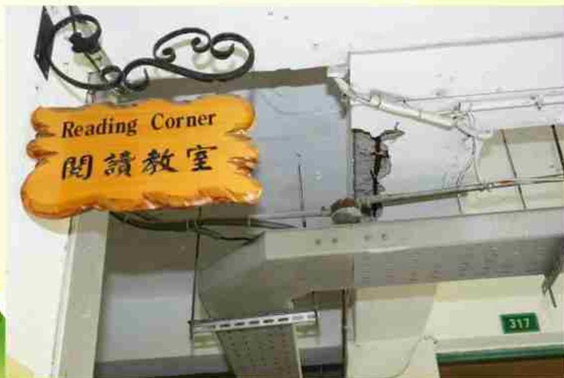
梁底混凝土剝落、天花板掉落
